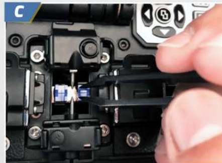
Remoção de pedaços de fibras rompidas
